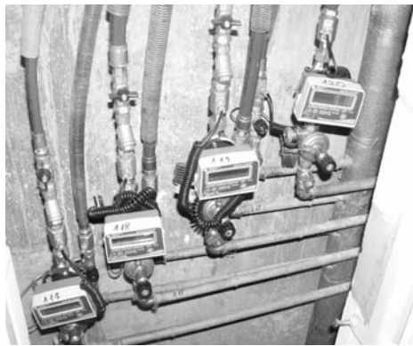
Рис. 9.12. Размещение квартирных тепломеров на лестничной площадке
