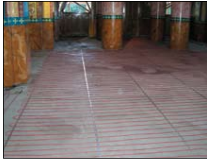
Церковь в Киеве (работы выполнены компанией ЧП «Арсан», г. Киев)
