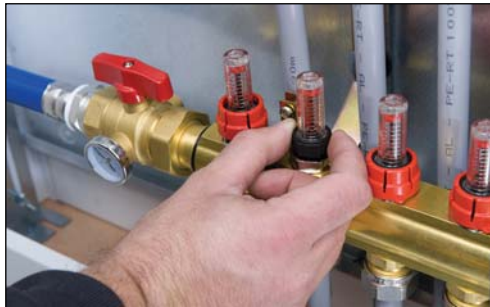
Рис. 11. Коллектор напольного отопления с ротаметрами
